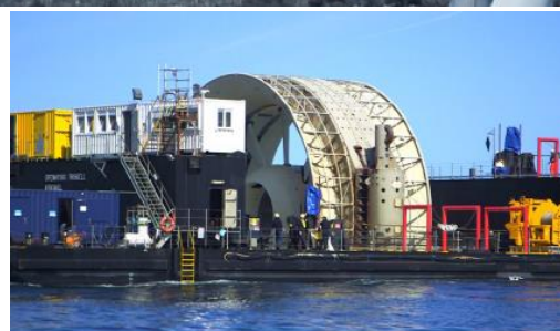
Hydrolienne Open Hydro sur la barge d'installation
